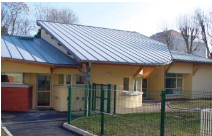
Les bâtiments de la mini-crèche « Les Alizés », inaugurée ce mois-ci avenue Carnot.
