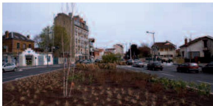
Embellissement en cours de « l'îlot Voltaire ».
